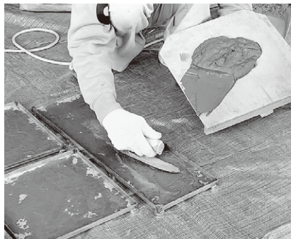
フリースタイルグレーチングにコンクリートを敷く。
